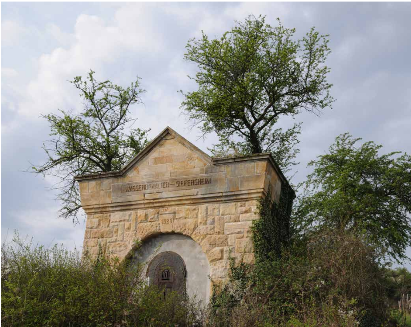
Alter Wasserbehälter in Siefersheim/Rheinhessen
