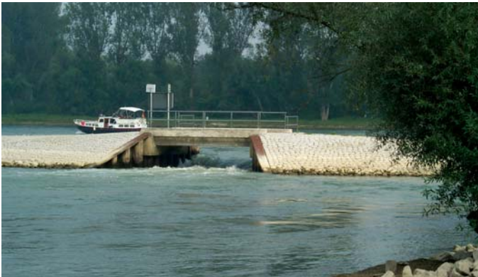
Bild 8: Einlassbauwerk zum Leimersheimer Altrhein
