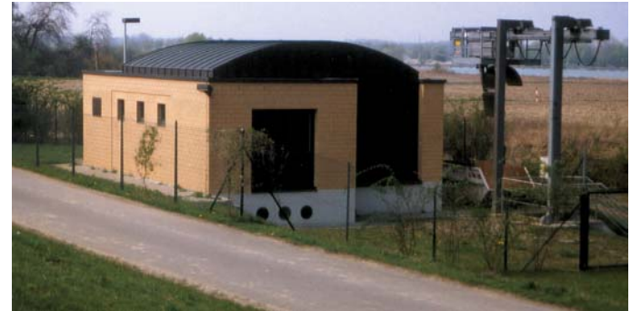
Bild 25: Neues Schöpfwerk Hagenbach
