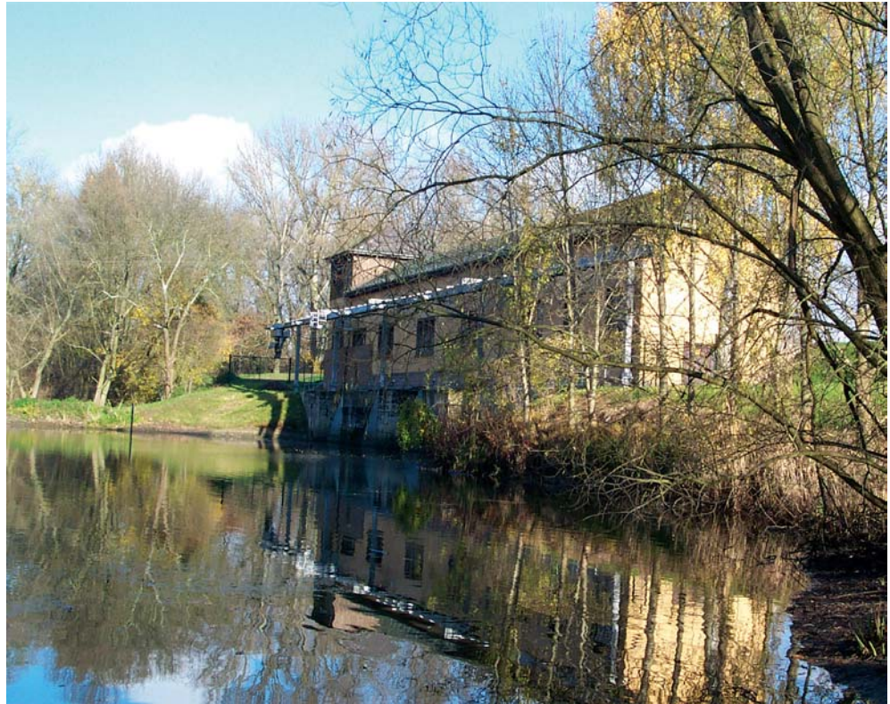
Bild 4: Schöpfwerk Sondernheim Süd
