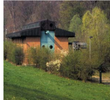
Bild 14: Neues Schöpfwerk Wörth
