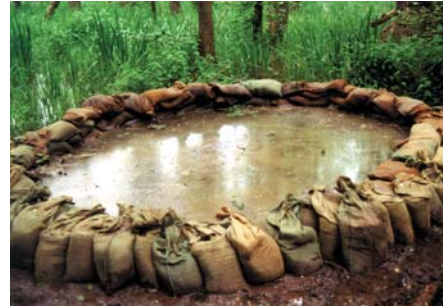
Bild 23: Sickerwasseraustritt binnenseits
