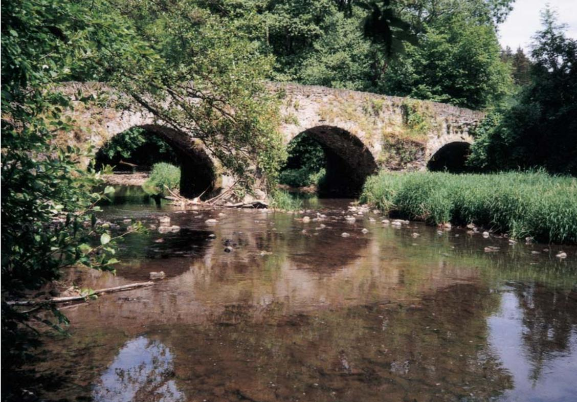
Sehr gut erhaltene Bruchsteingewölbebrücke mit drei eindrucksvollen halbkreisförmigen Durchflussöffnungen. Der Kern des Bauwerks stammt aus dem Mittelalter, die Brücke wurde im 18. Jahrhundert renoviert.
