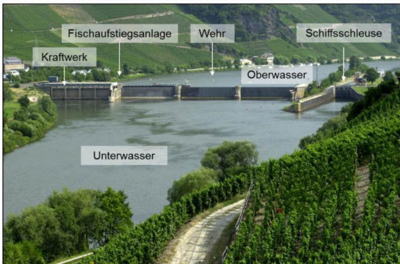
**Abbildung 2.7:** oben: prinzipieller Aufbau eines Moselkraftwerks, unten: Foto des Kraftwerks Wintrich mit Blick vom Unterwasser (Foto: RWE POWER AG)
